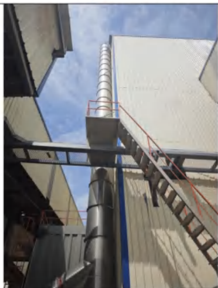
图 9 三破和四破废气排放口 (DA002)
