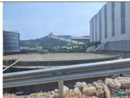
图 30 洗砂废水废水处理设施
