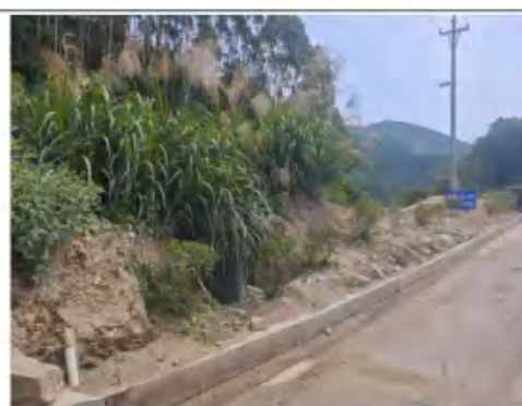
图 32 初期雨水环形收集沟
