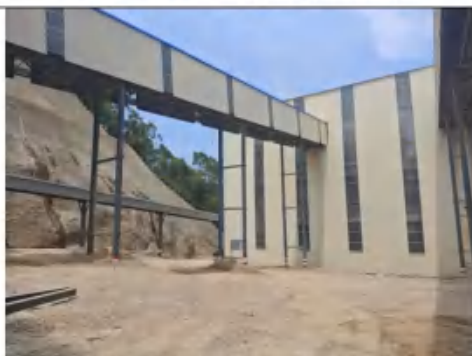
图 21 水洗砂密闭厂房
