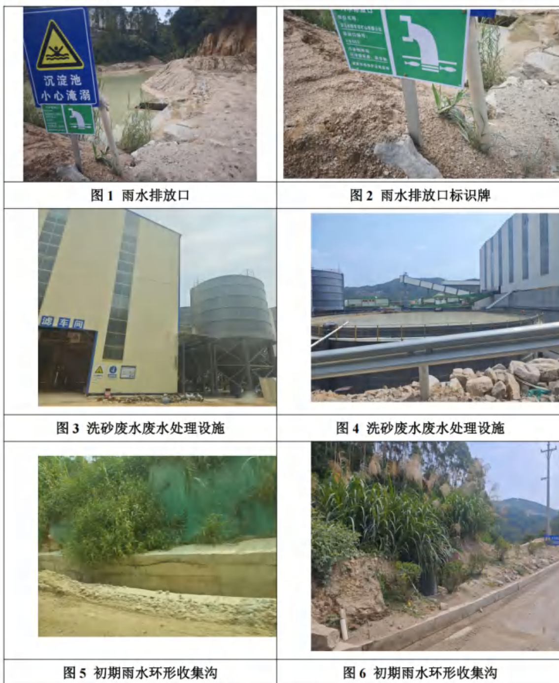
图 3.5-2 厂区废水处理设施图
