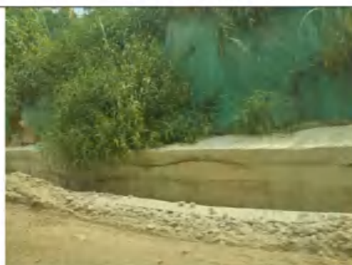
图 31 初期雨水环形收集沟
