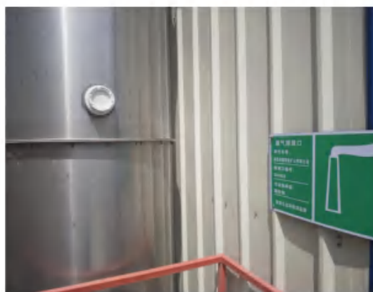
图 10 DA002 排放口标识牌
