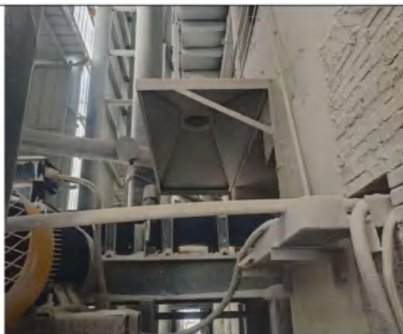
图 3 破碎区集气罩
